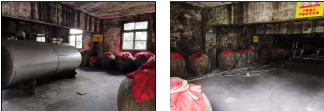
图 2-8 现状照片（酒库区，不锈钢储罐和陶坛罐）
