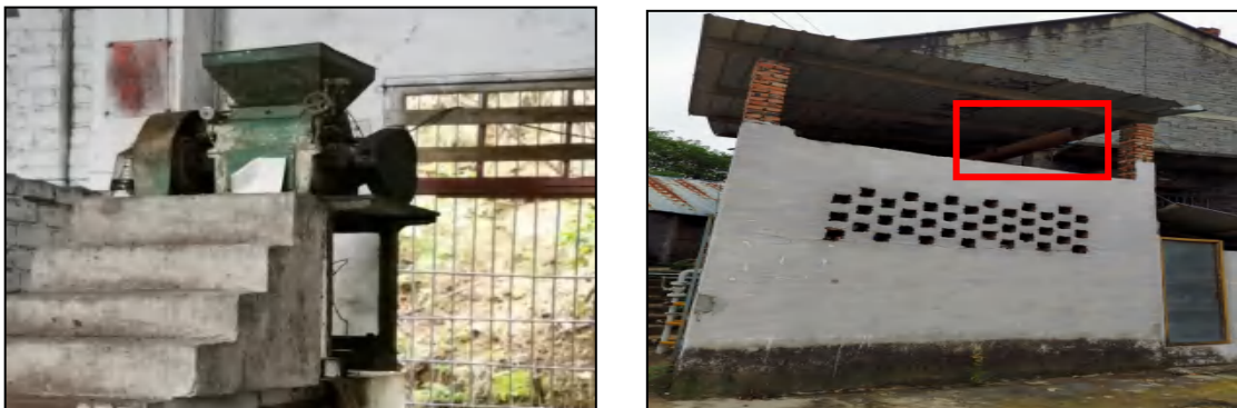
图 2-9 现状照片（左粉碎机，右锅炉房及排气筒）
