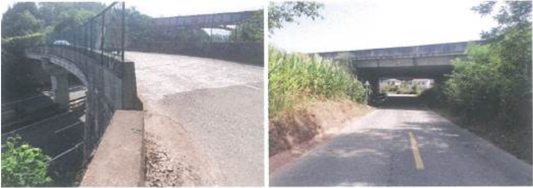
现状照片 跨越现状渝蓉高速
