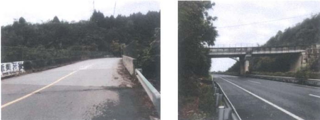
现状照片 跨越现状遂资眉高速
