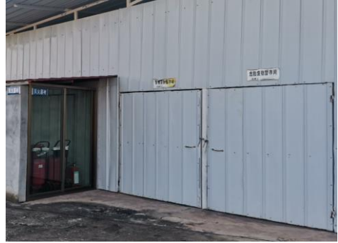
一般固废暂存间和危废暂存间
