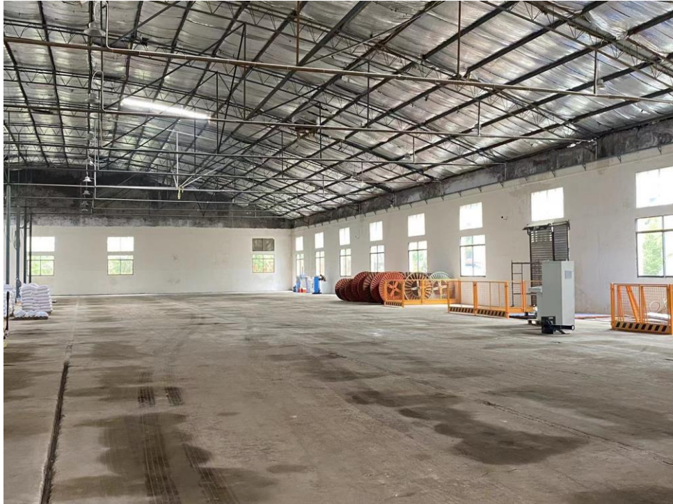
图 2-5 本项目租赁厂房现状
